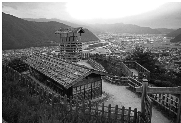
図4 荒砥城の再建建物群
