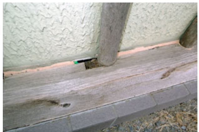
写真 100 土台の腐朽
