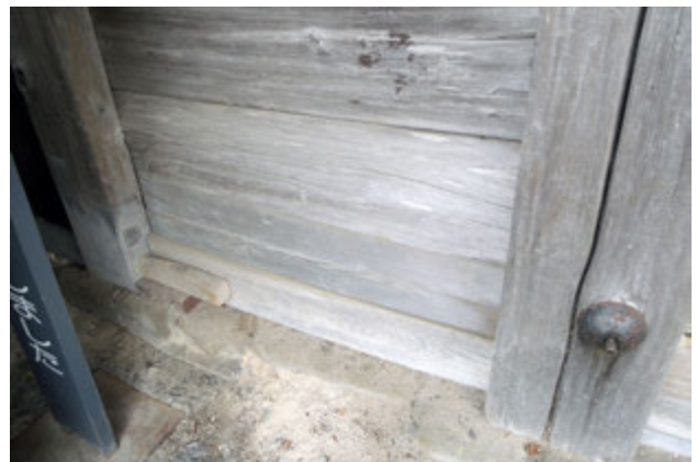
写真 79 壁板の外れ
