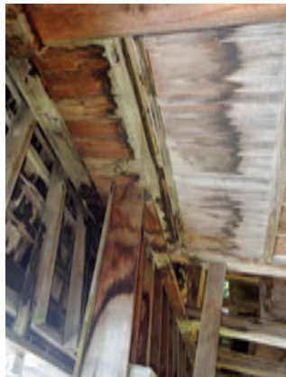
本丸中馬屋 屋根の雨漏りが進行
