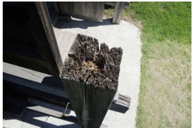
写真 56 控え柱の損傷
