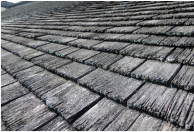
写真10 屋根の劣化
