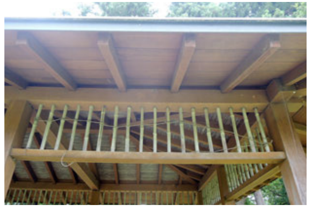
写真 102 小壁竹縄の外れ
