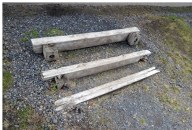
写真 120 木階段の損傷
