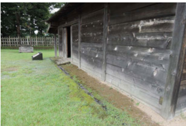
写真 84 奥御殿板蔵の三和土
