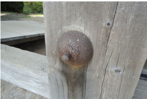
写真 80 金物の損傷
