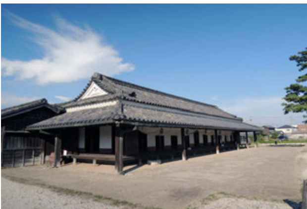
写真 112 軟質土系舗装 (真砂土 + 中性固化材) の例 (静岡県湖西市・特別史跡新居関跡)
