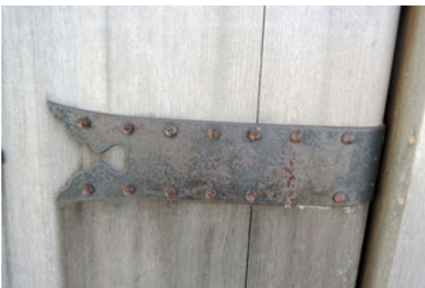
写真 57 金物の損傷
