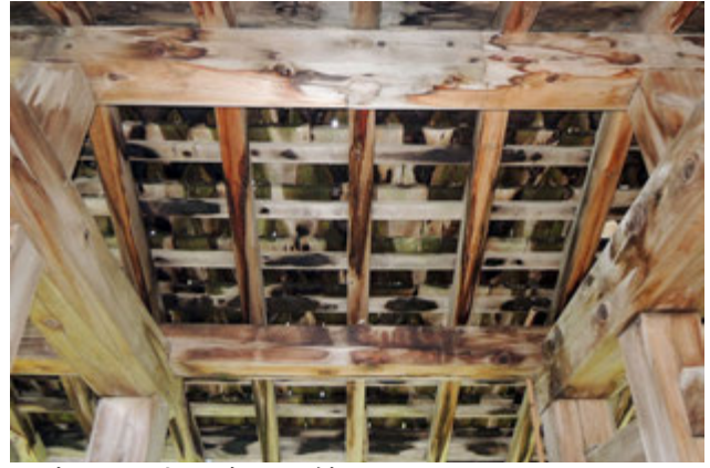
写真 49 小屋裏の雨染み
