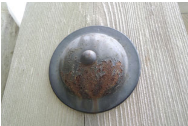
写真 68 金物の損傷
