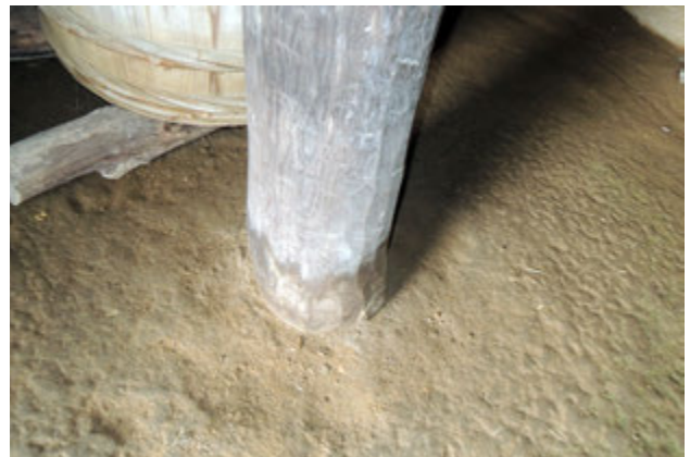
写真 32 柱脚の雨染み
