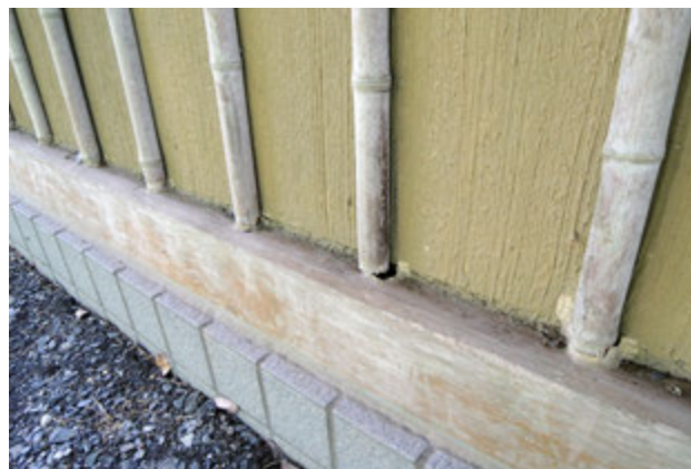
写真 98 外部竹の外れ
