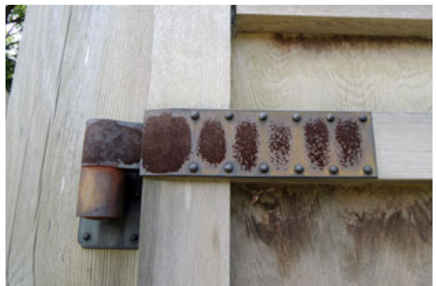
写真 69 金物の損傷
