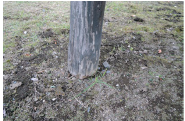
写真 42 柱脚部腐朽
