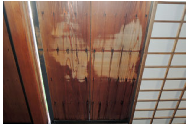
写真 21 建具の損傷と劣化
