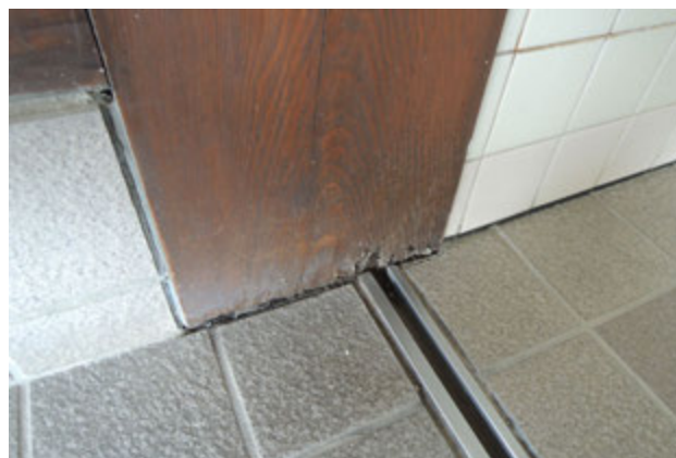
写真 118 柱脚の腐朽
