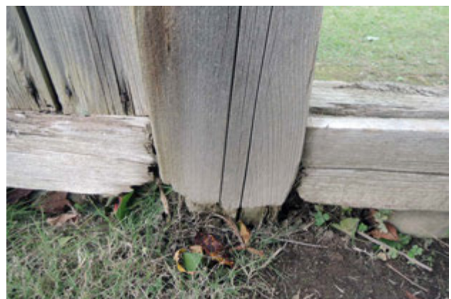
写真 75 柱脚の損傷
