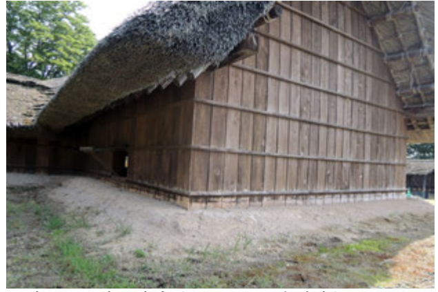
写真 40 壁の変色と周囲の三和土割れ
