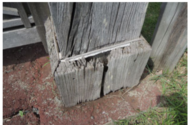
写真 61 柱脚と幅木の損傷
