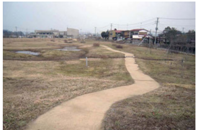
写真 111 透水性真砂土舗装の例 (群馬県みどり市・史跡西鹿田中島遺跡)
