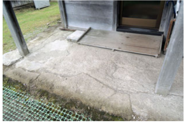
写真 24 三和土の割れ
