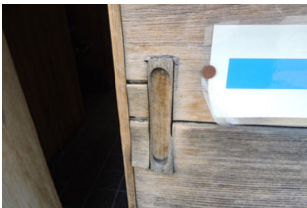
写真 116 入口建具取手の削れ
