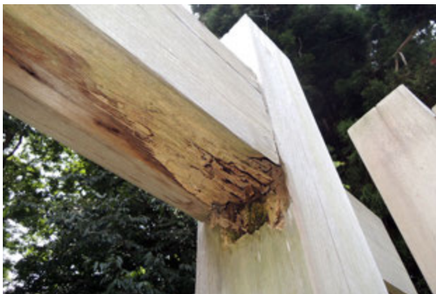
写真 66 冠木の腐朽 まぐさが紛失している
