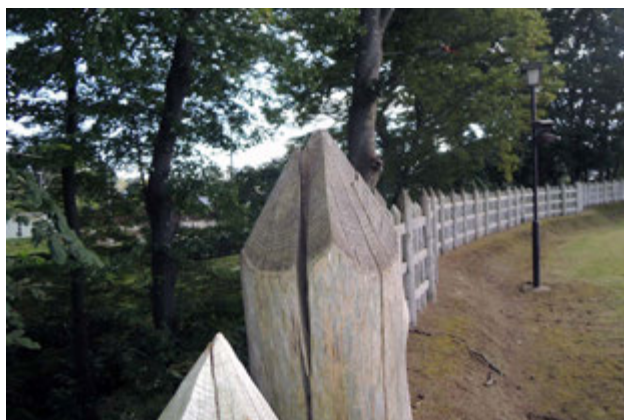
写真 70 柱の割れ
