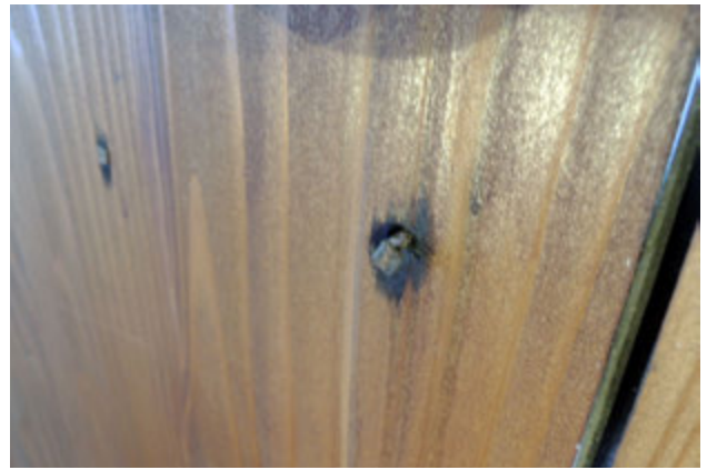
写真 19 建具の損傷と劣化
