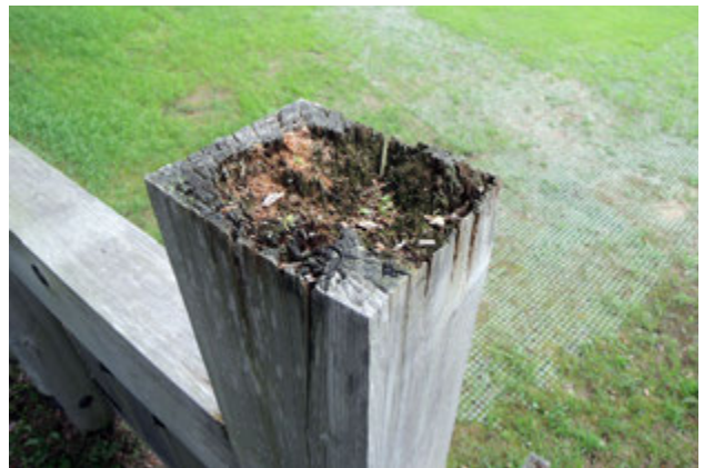
写真 65 柱頭の損傷
