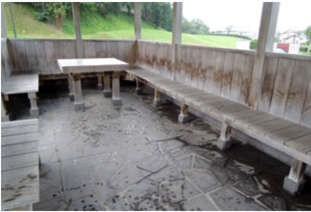
写真 101 内部腰壁とベンチの雨染み
