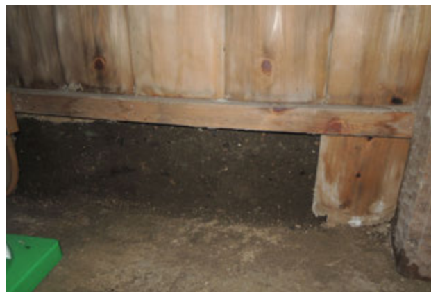
写真 38 板壁の損傷
