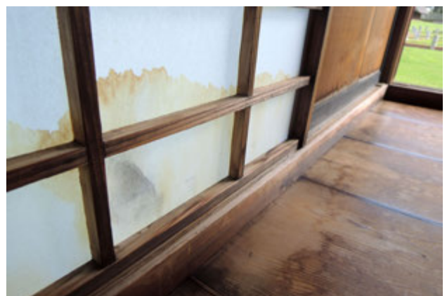
写真17 建具の損傷と劣化
