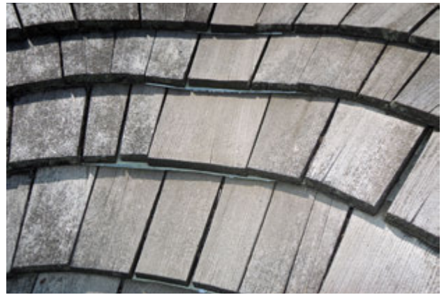
写真11 屋根の劣化 谷部分に銅板が敷いてある。
