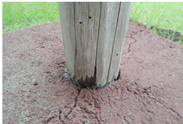
写真 95 柱脚の損傷
