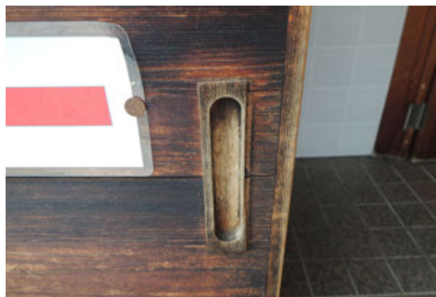
写真 117 入口建具取手の削れ
