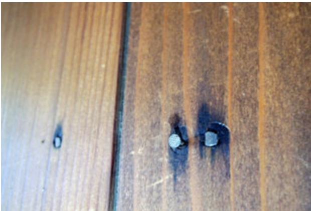
写真 20 建具の損傷と劣化
