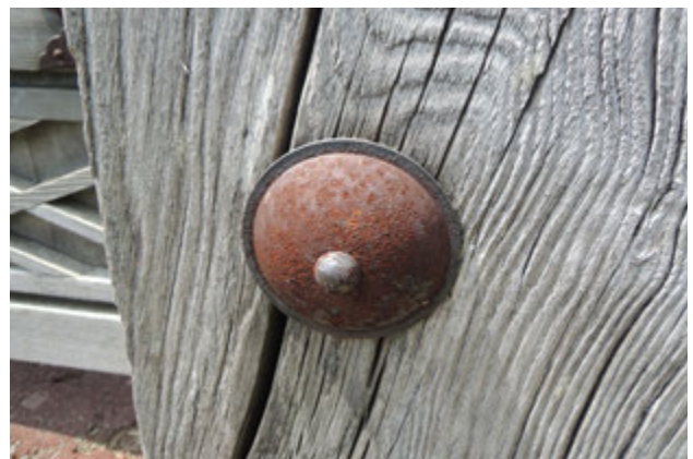
写真 63 金物の損傷
