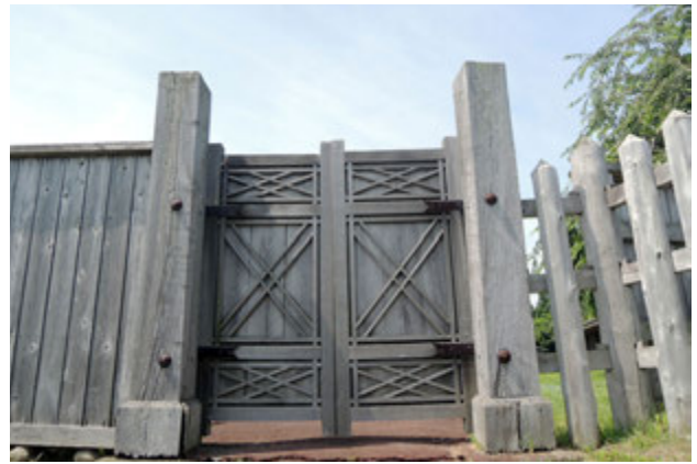
写真 59 柱の損傷 柱の傾きが見られる
