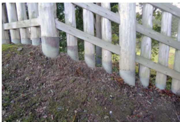
写真 72 柱脚銅板の露出
