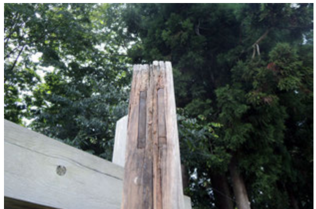
写真 67 建具の框の損傷
