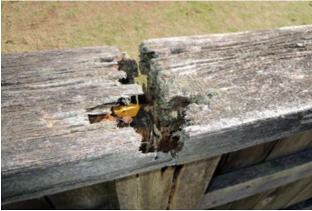
写真 76 笠木の損傷
