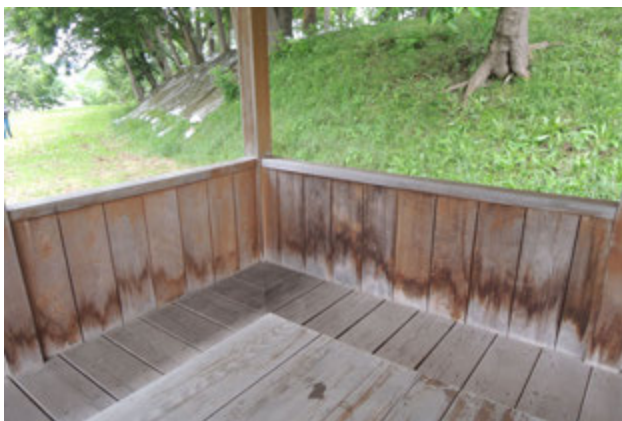
写真 97 内部腰壁とベンチの雨染み
