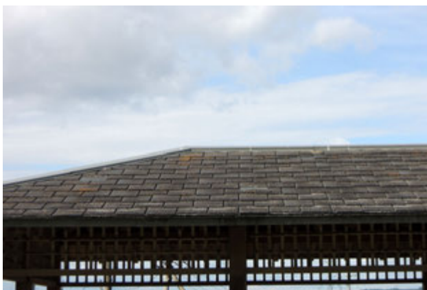
写真 99 屋根板の外れ
