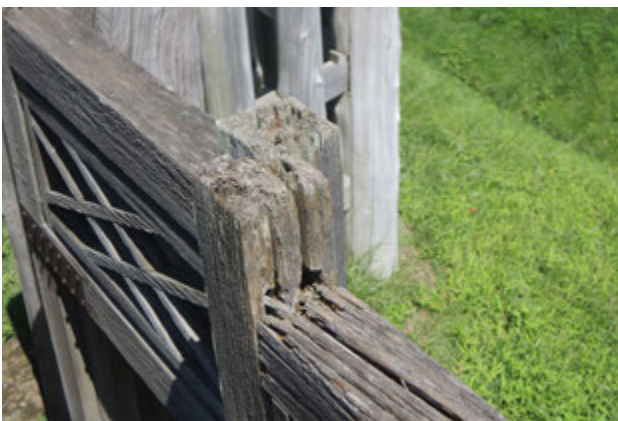
写真 62 建具の框の損傷
