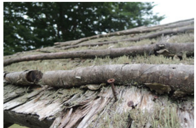
写真 44 屋根杉皮の劣化
