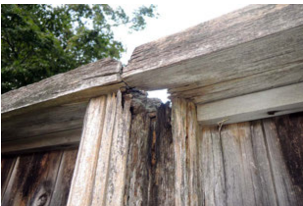
写真 74 柱頭の損傷
