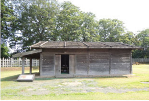
写真 35 屋根全体の損傷
