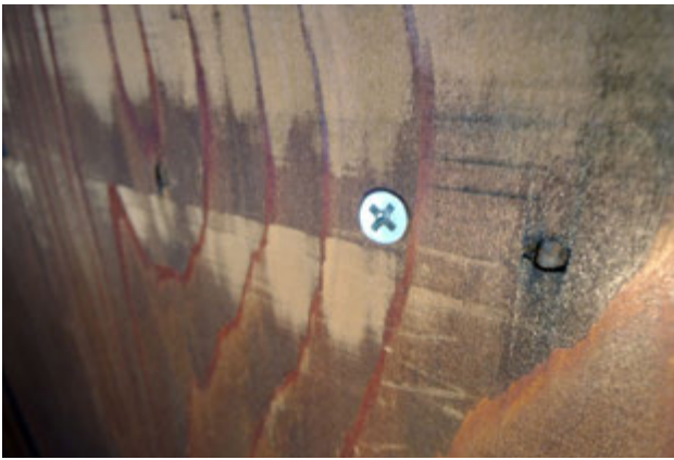
写真 18 建具の損傷と劣化
