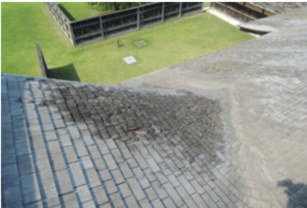
写真12 屋根の劣化
