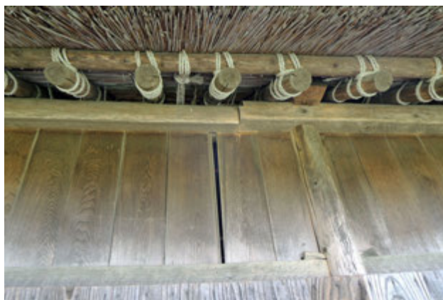
写真 96 小壁縦板の隙間
