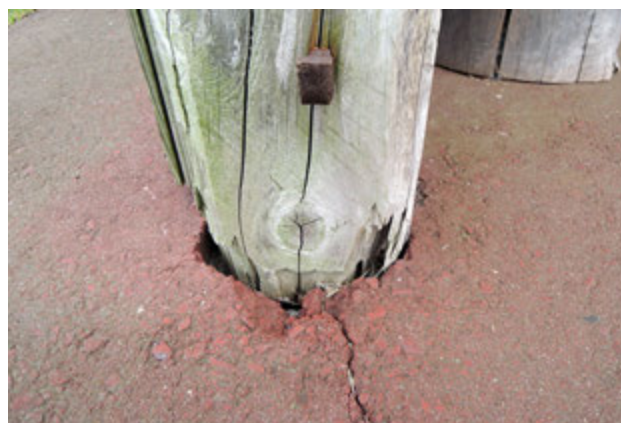
写真 46 柱脚の損傷
