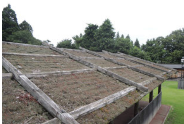
写真 45 屋根の劣化
