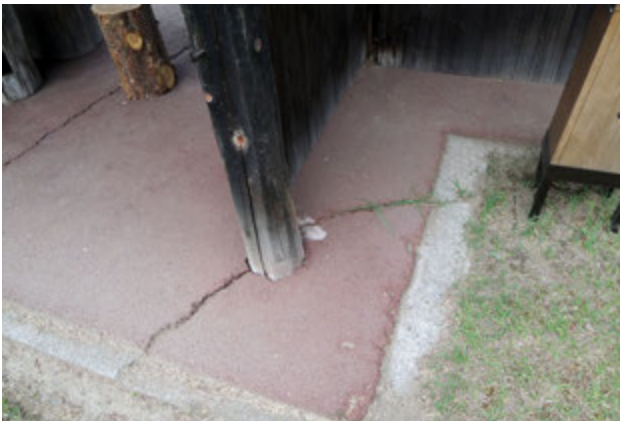
写真 47 舗装の割れ
