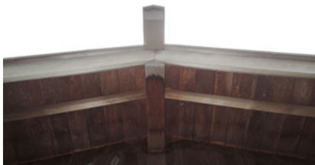
写真 90 破風板の雨染み
