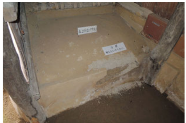
写真 34 内部三和土の損傷
