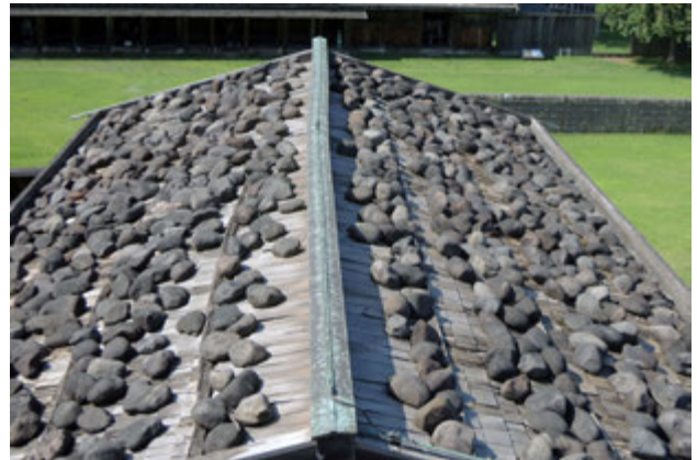
写真 25 棟木の変形
