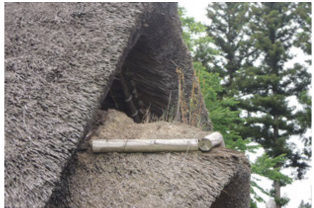
写真 30 納屋 2 の屋根 出入口芝棟の劣化
