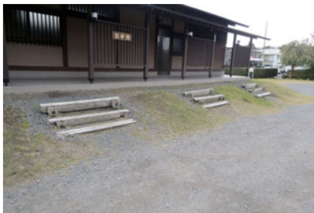
写真 119 木階段の損傷
