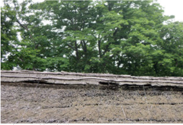
写真 39 棟の損傷
