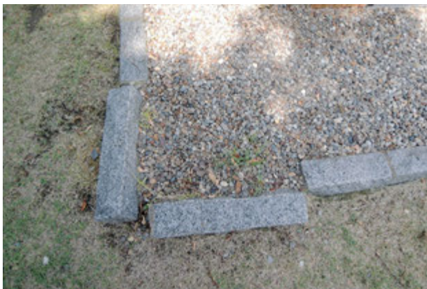
写真 114 外部縁石の外れ
