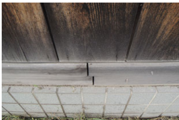
写真 92 土台継手の隙間
