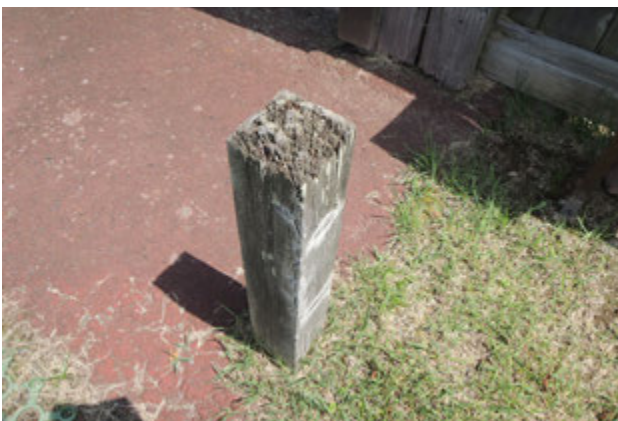
写真 60 控柱の損傷
