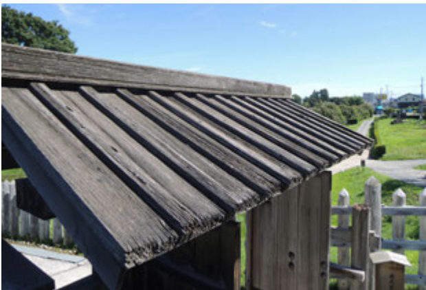
写真 55 屋根の損傷
