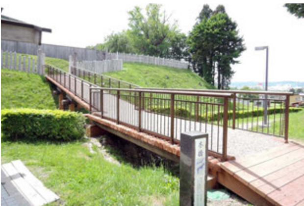
写真 51 現状の木橋 平成 29 年に改修工事を行った
