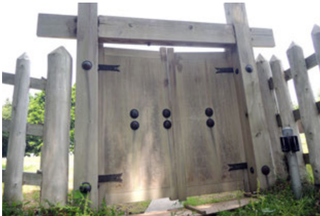
写真 64 軸部全体の損傷
