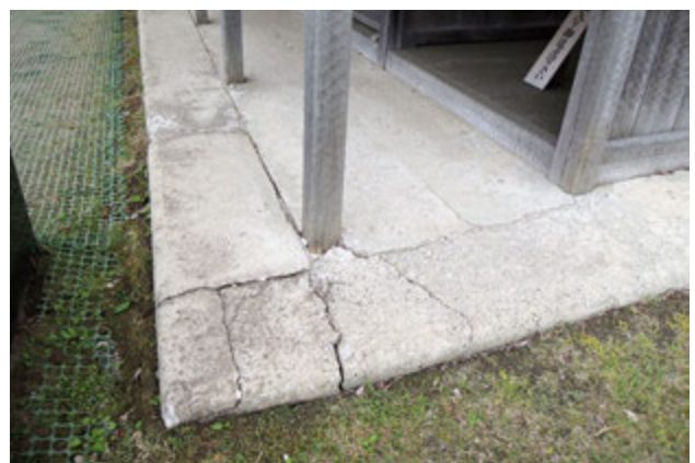
写真 27 三和土の割れ
