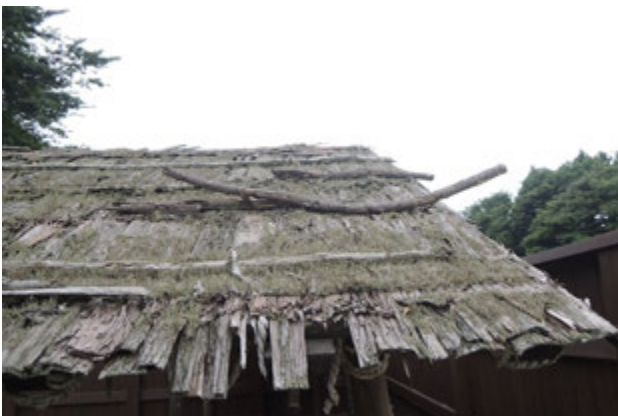
写真 43 屋根の劣化
