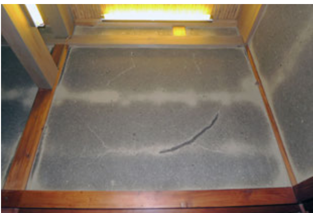
写真14 壁の損傷と変色
