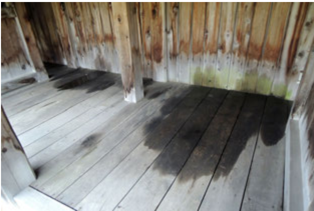
写真 50 床板の雨染み
