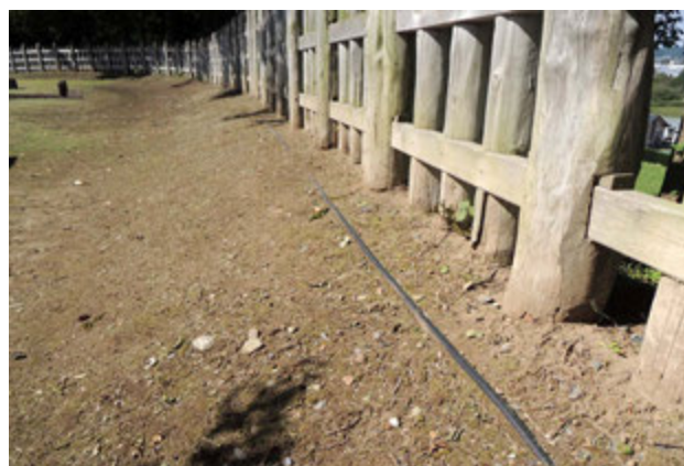
写真 73 設備ケーブルの露出
