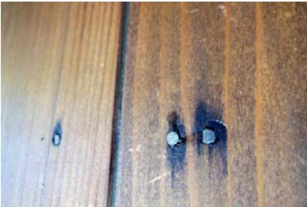
写真 20 建具の損傷と劣化
