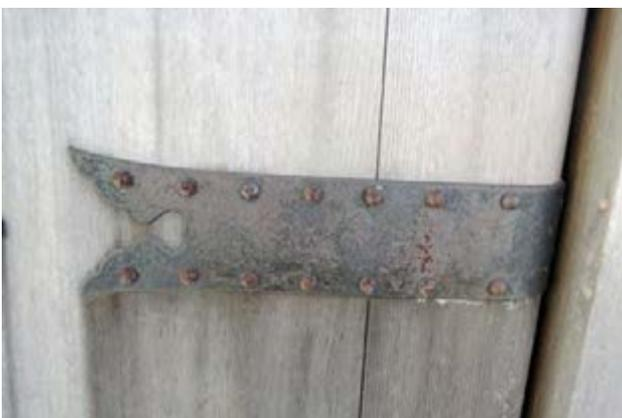
写真 57 金物の損傷
