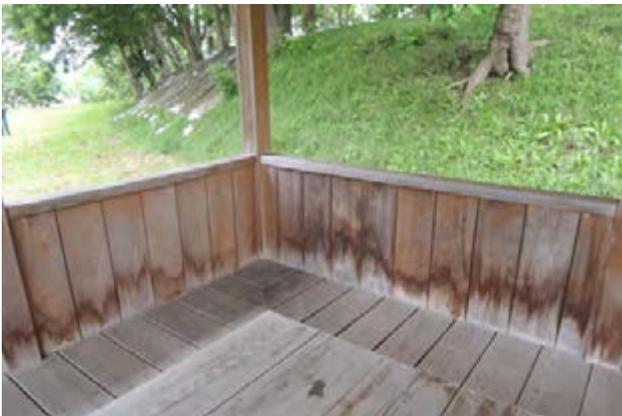
写真 97 内部腰壁とベンチの雨染み
