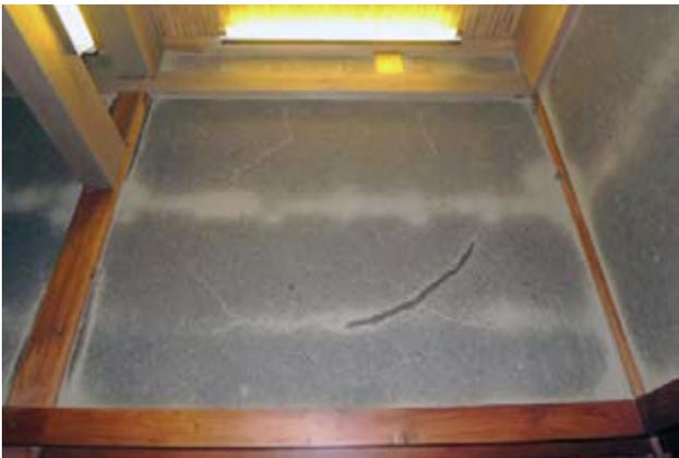
写真14 壁の損傷と変色
