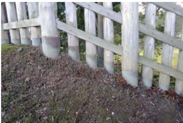
写真 72 柱脚銅板の露出
