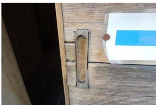
写真 116 入口建具取手の削れ
