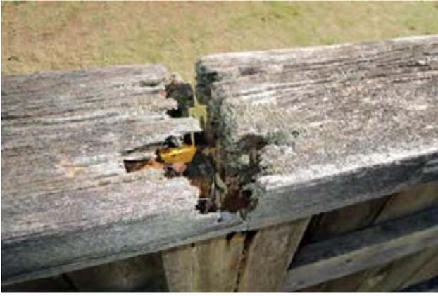
写真 76 笠木の損傷
