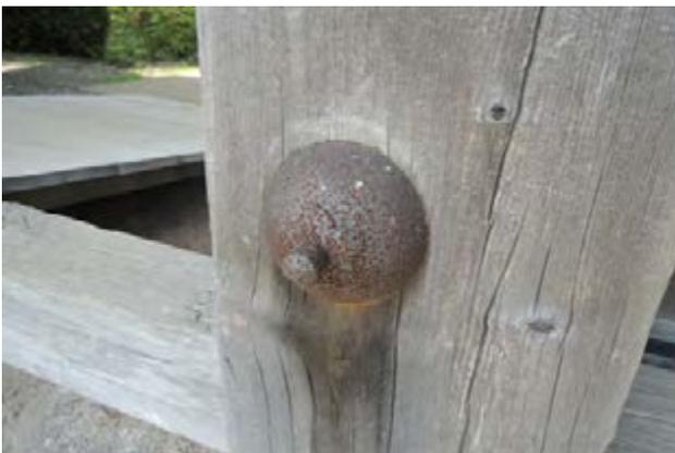
写真 80 金物の損傷
