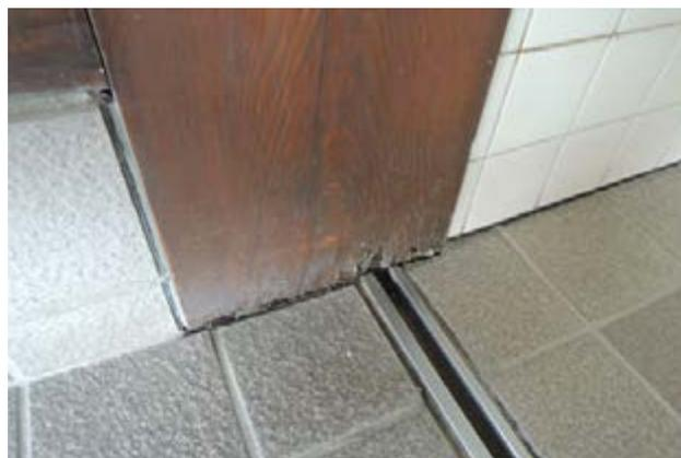
写真 118 柱脚の腐朽
