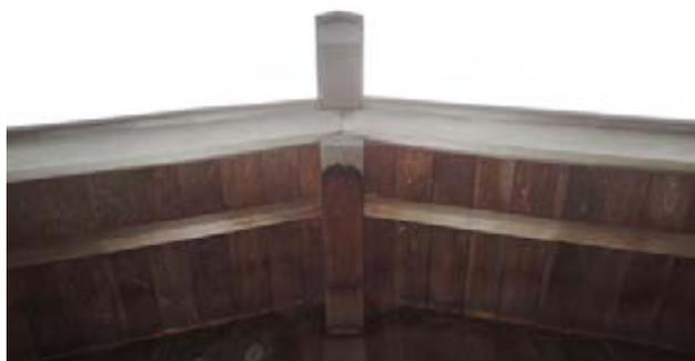
写真 90 破風板の雨染み
