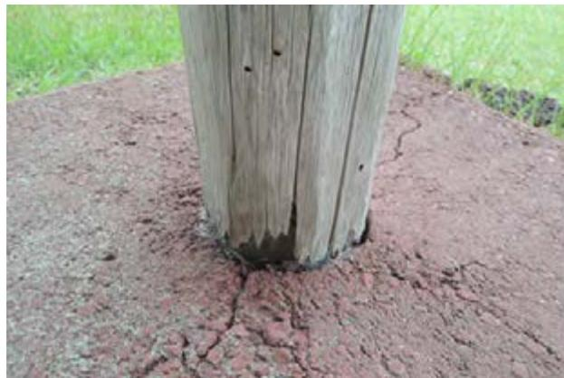
写真 95 柱脚の損傷
