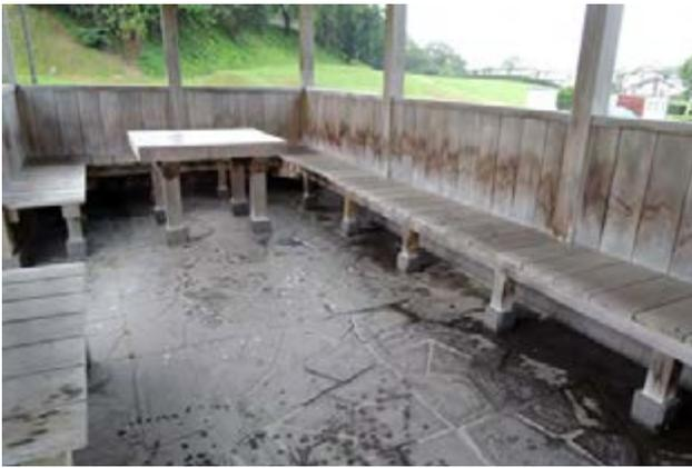
写真 101 内部腰壁とベンチの雨染み
