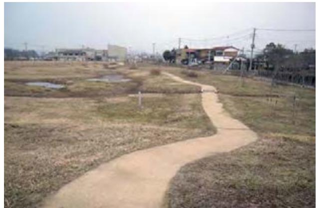
写真 111 透水性真砂土舗装の例
