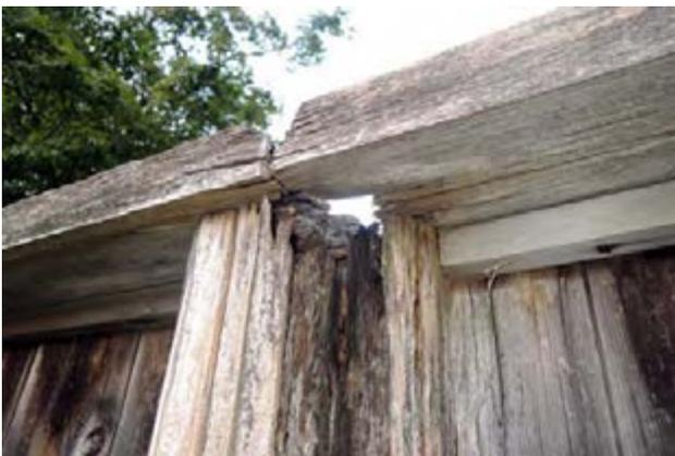
写真 74 柱頭の損傷
