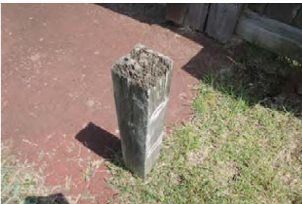
写真 60 控柱の損傷
