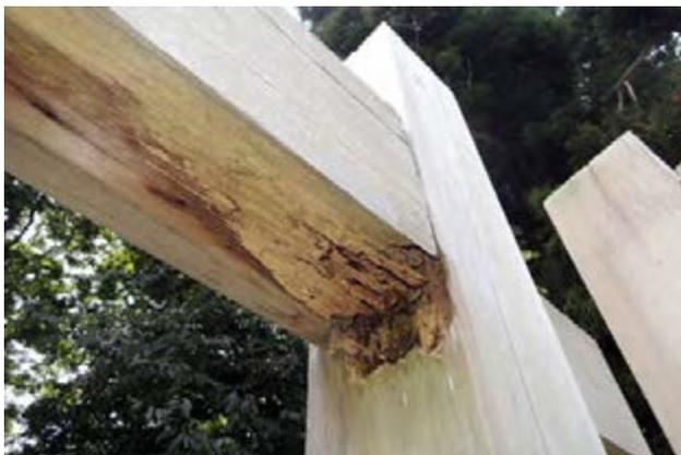
写真 66 冠木の腐朽 まぐさが紛失している
