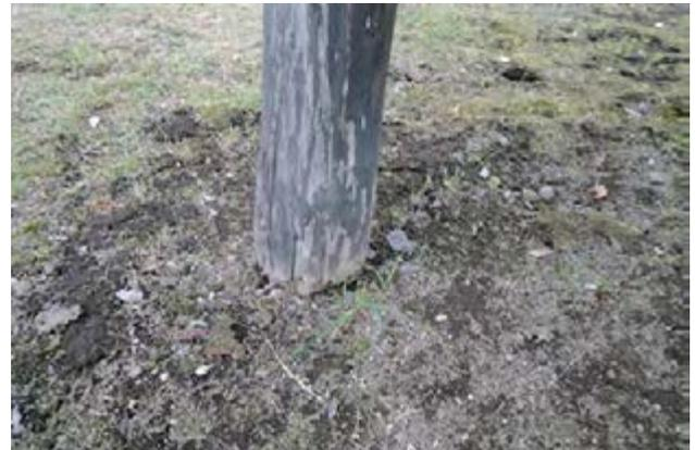
写真 42 柱脚部腐朽
