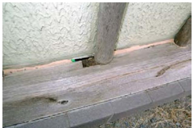
写真 100 土台の腐朽
