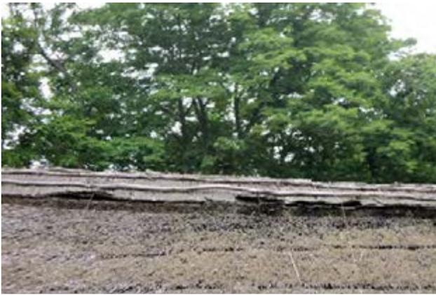
写真 39 棟の損傷
