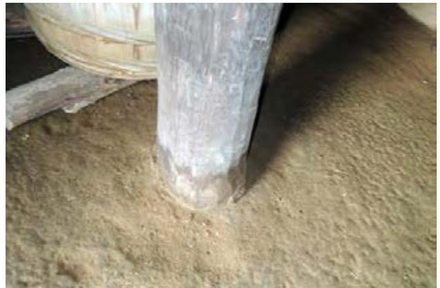
写真 32 柱脚の雨染み
