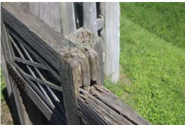
写真 62 建具の框の損傷
