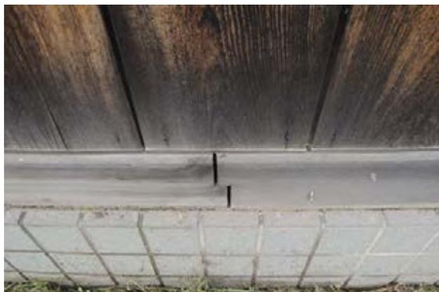
写真 92 土台継手の隙間
