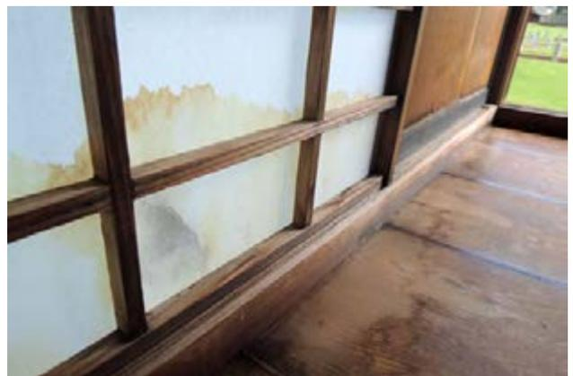
写真17 建具の損傷と劣化
