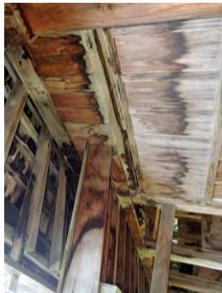
本丸中馬屋 屋根の雨漏りが進行
