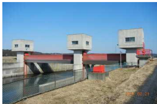
新頭首工全景(揚水していない時)
