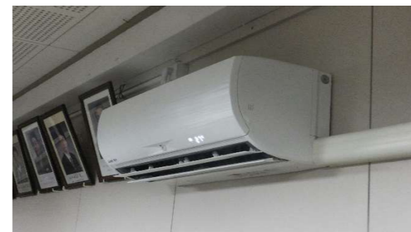
会議室へのエアコン設置
