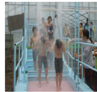
補修したシャワー
