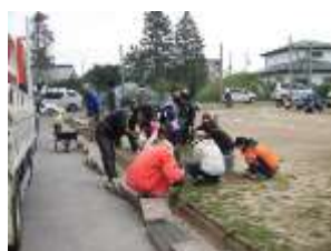
側溝の泥上げ
