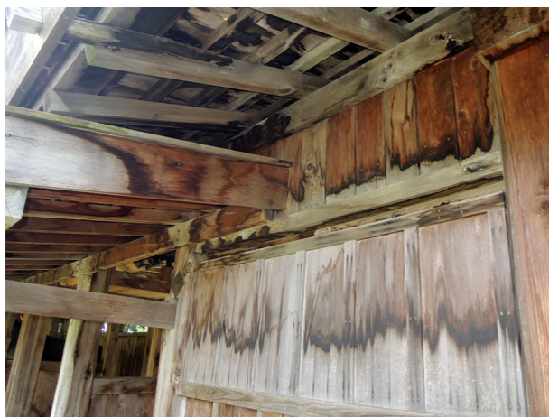
本丸中馬屋 屋根の雨漏りが進行
