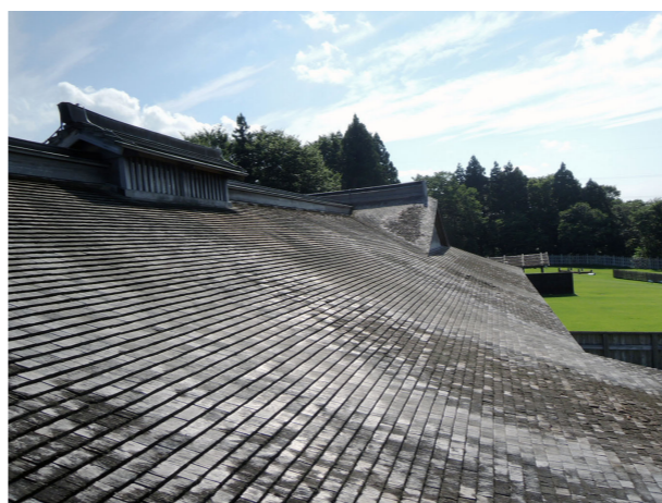
本丸主殿 屋根材の劣化が目立つ
